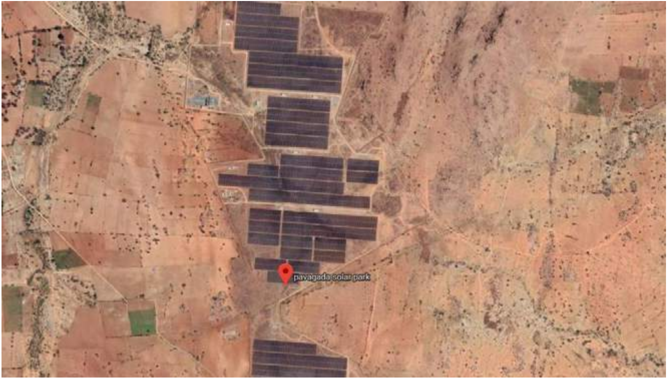
Pavagada Solar Park
